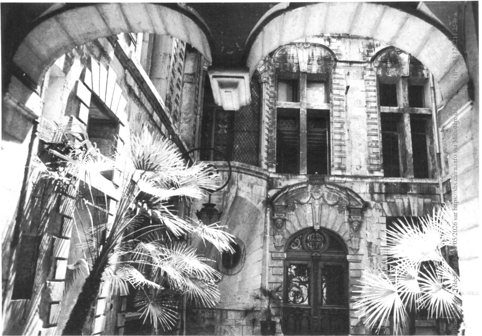
7. Hôtel de Sarret ; vue générale de la cour. Au fond, à gauche balcon sur trompe.
