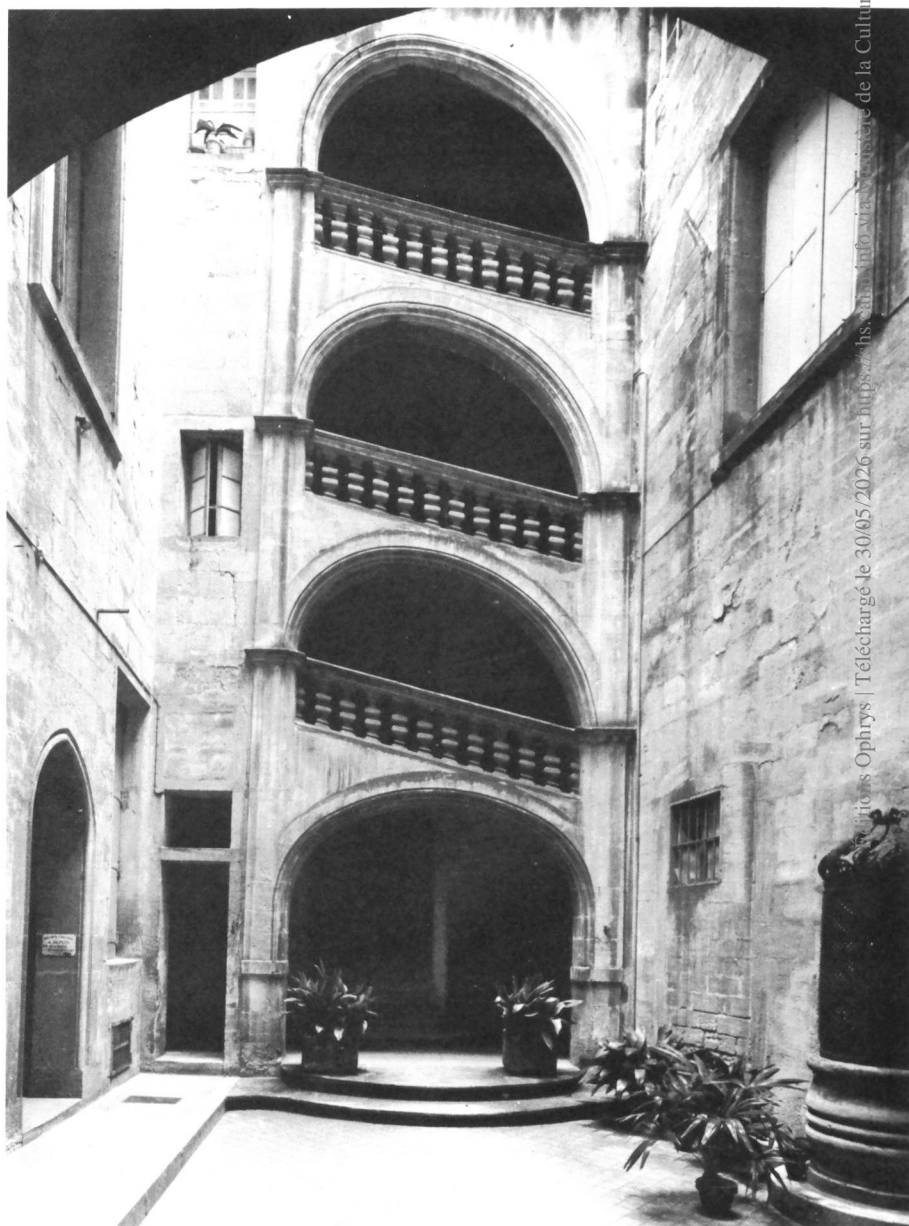
2. Hôtel de Mirman, vue générale de la cour.
